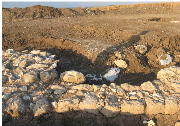
איור 12: מיקום חתך 1 לפני החפירה.
